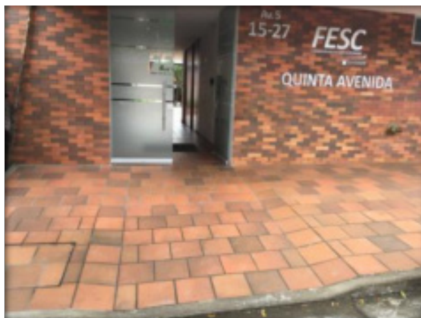
Imagen 1. Entrada Principal Edificio Quinta Avenida
