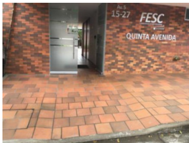
Imagen 1. Entrada Principal Edificio Quinta Avenida
