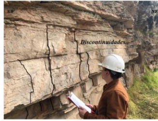
Figura 10. Levantamiento de discontinuidades.
